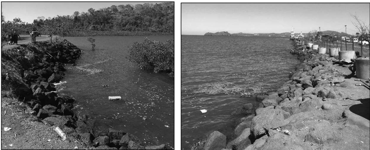
Figure 9 : Cordon protecteur au nord de la zone
