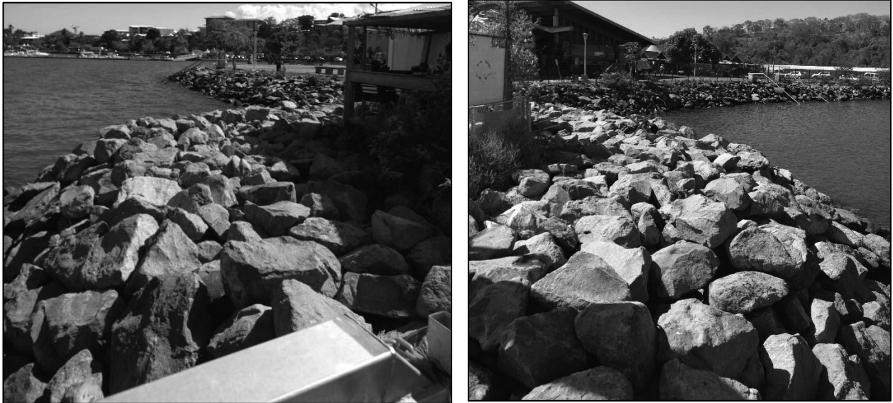
Figure 11 : Vue de la partie ouest de l'enrochement
