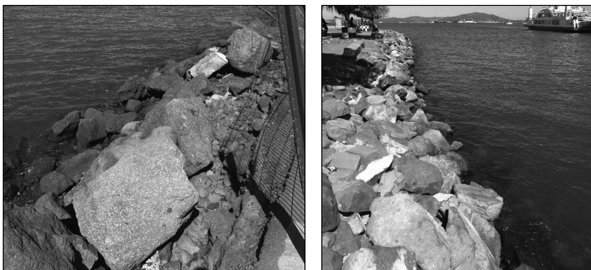
Figure 10 : Dimensions des blocs et dispositions
